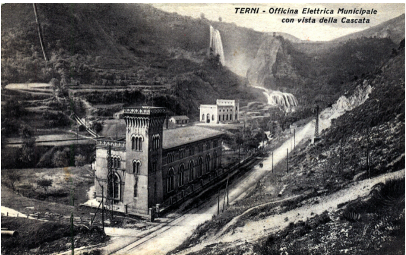
Fig. 5. La centrale del Comune di Terni e in secondo piano quella di Marmore, anni Venti.
