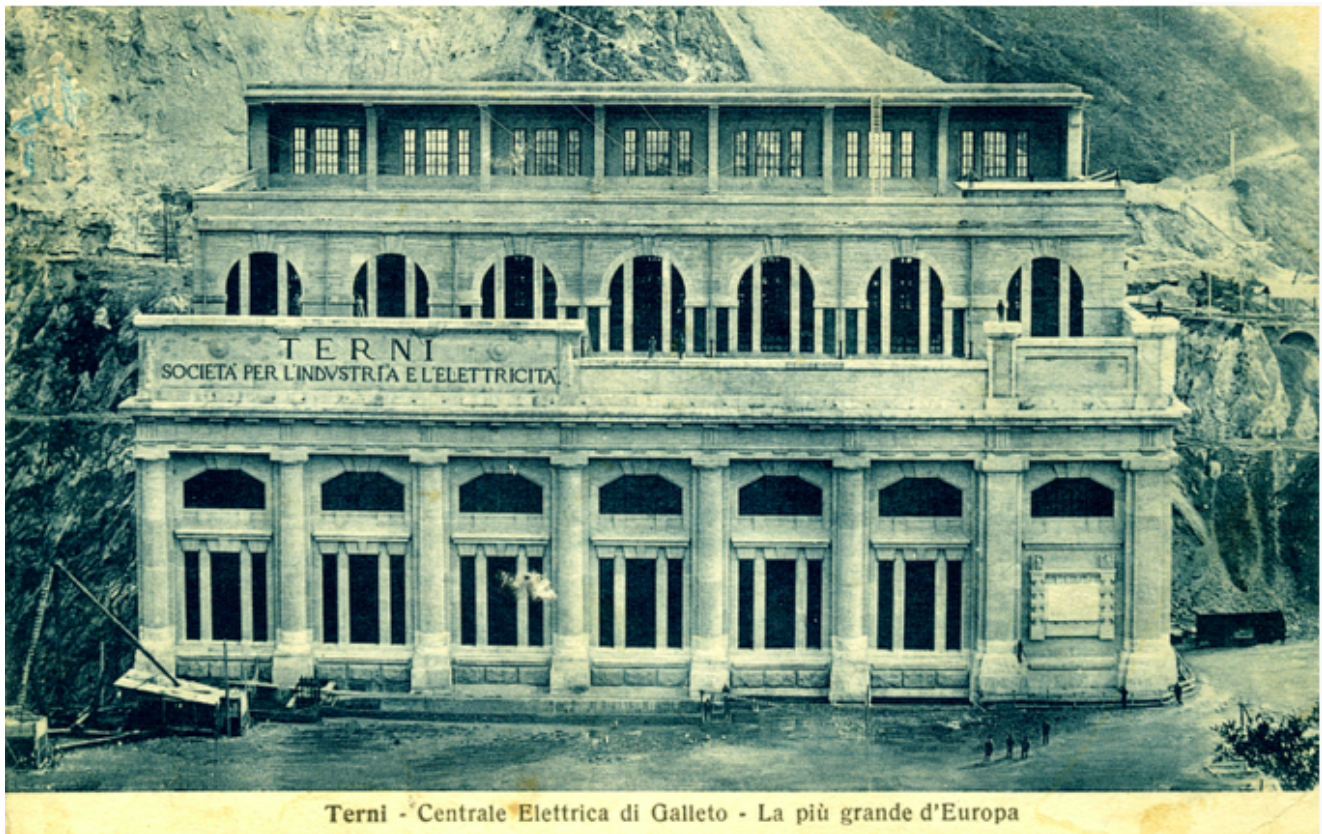
Fig. 6. La centrale di Galleto in fase di ultimazione, fine anni Venti.
