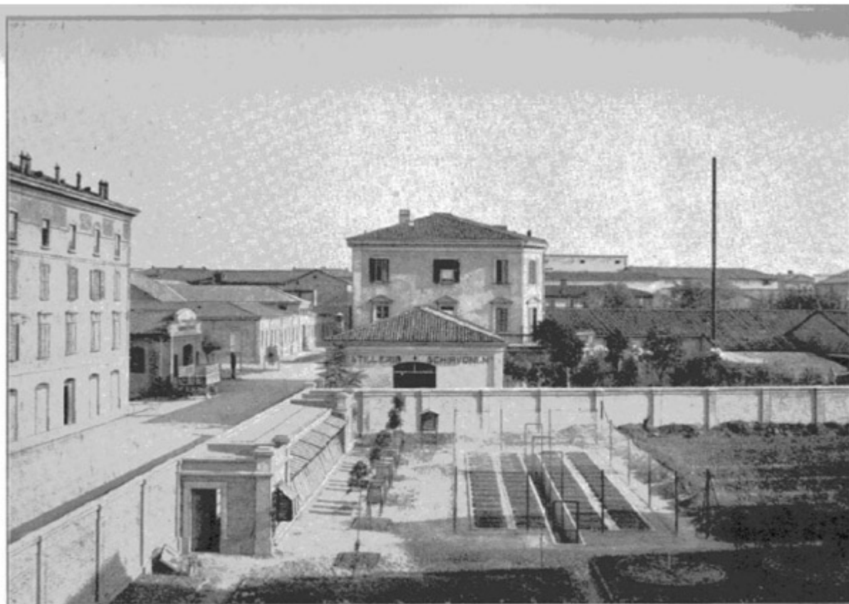
Impianto di casse da vegetazione con raccolta dei liquidi di percolamento
