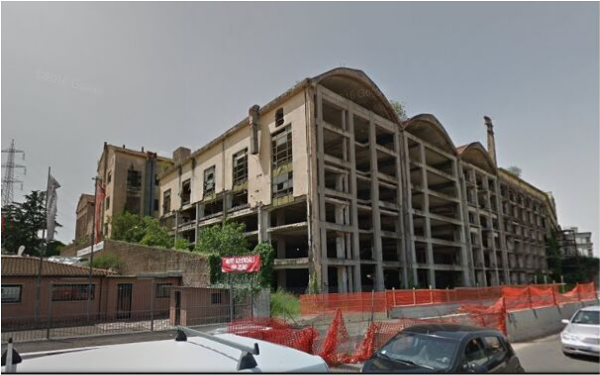
Fig.1 La facciata del rudere della Leo Penicillina, al decimo chilometro della via Tiburtina.
