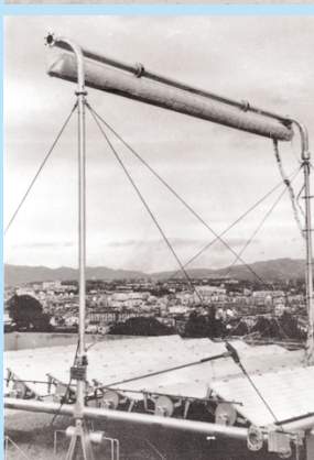
Figura 3. Il primo impianto dimostrativo a concentrazione puntuale (a torre con specchi piani) costruito nel 1965 a S. Ilario (Genova) (foto Musil, Brescia).
